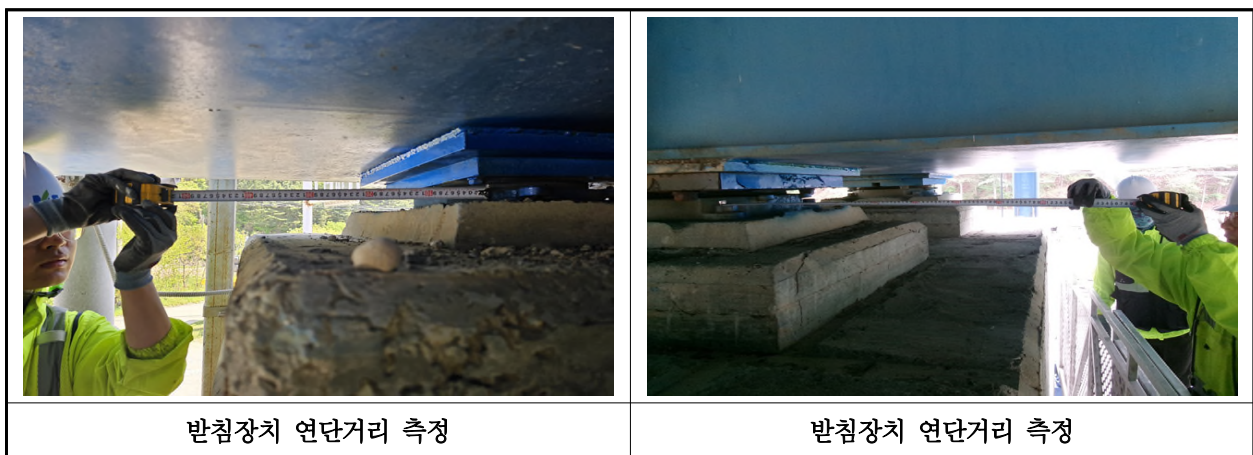
【사진 4.3.14】 교량받침장치 연단거리측정
