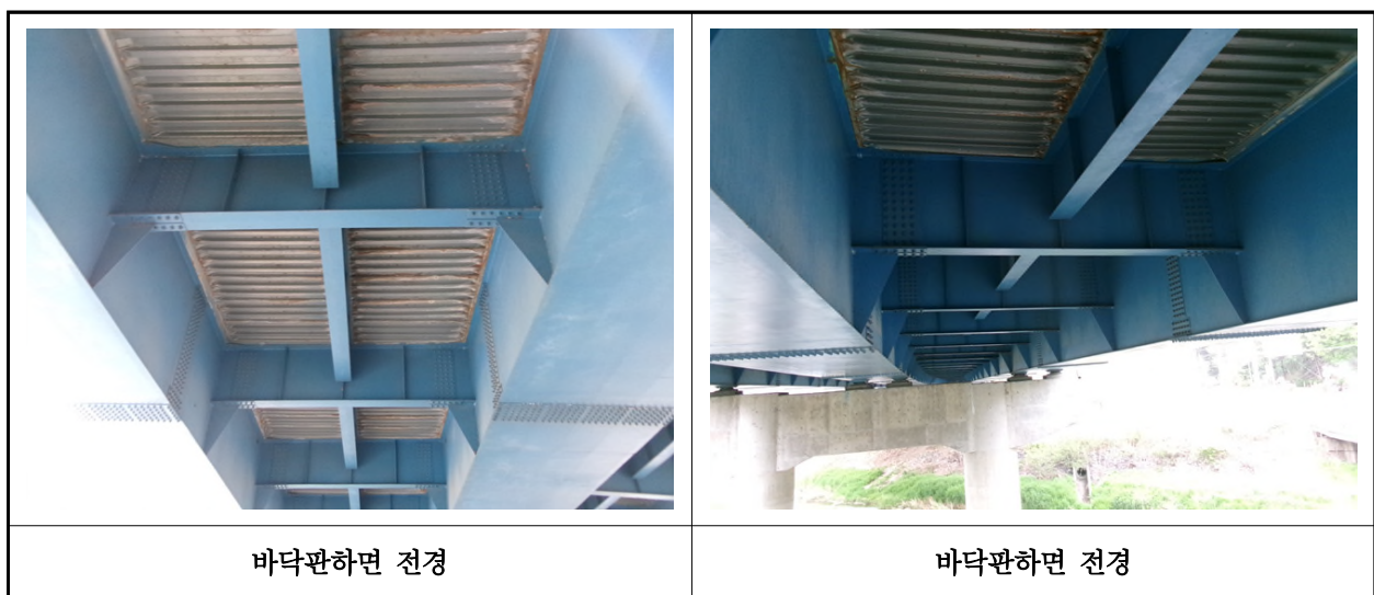
【사진 4.3.2】 바닥판하면 전경
