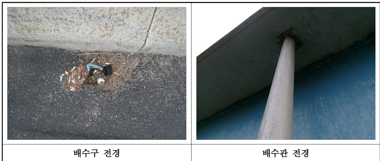
【사진 4.3.21】 배수시설 전경
