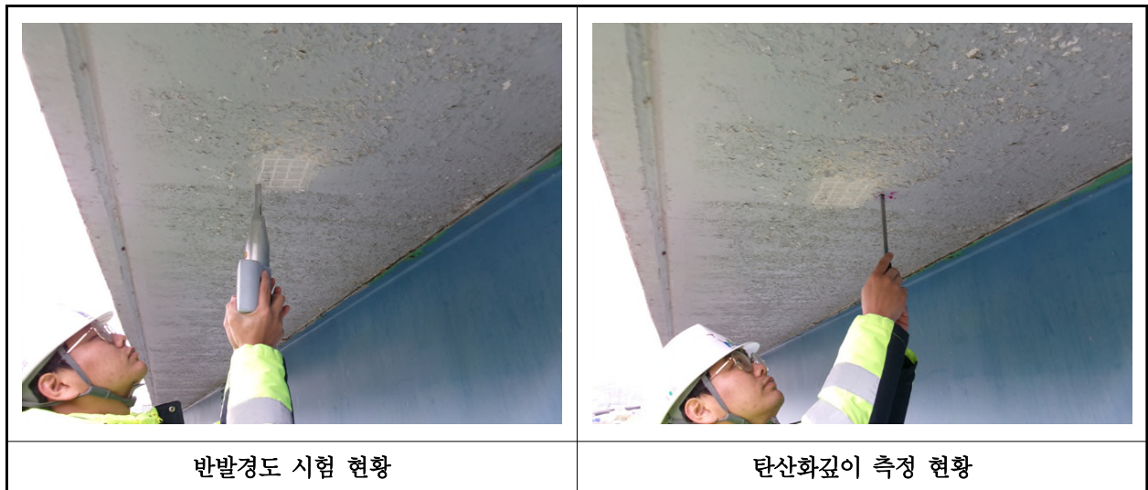
【사진 4.4.1】 콘크리트 내구성조사 현황
