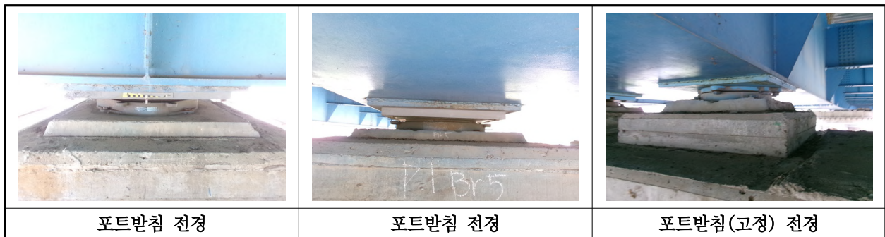
【사진 4.3.12】 교량받침 전경
