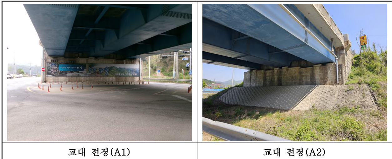
【사진 4.3.8】 교대 전경
